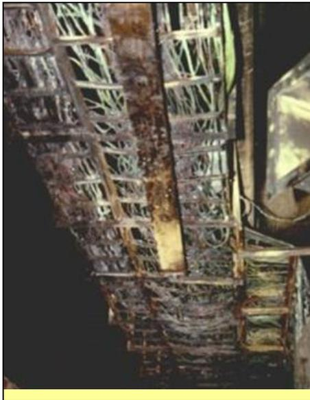
En 1997 un importante incendio afectó el centro de control de motores de un horno de cemento en la localidad de Olavarría (Argentina). Los cables fueron el medio de propagación del incendio que comenzó en la resistencia de arranque del motor de un molino. Los daños materiales alcanzaron a USD 4.500.000 de la época.
