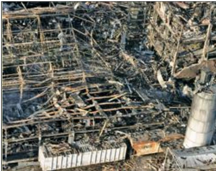
Las explosiones de azúcar son infrecuentes, sin embargo la explosión de la planta Imperial Sugars (Georgia, February 2008) provocó 14 muertos. La investigación indicó que la explosión comenzó en un elevador de cangilones y se propagó luego mediante explosiones secundarias. La investigación demostró que en algunos sitios la acumulación de azúcar alcanzaba 20 centímetros.
