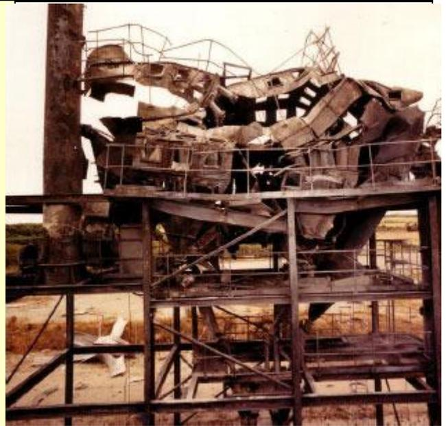
El silo que se muestra en la foto contenía carbón molido que era utilizado como combustible para un horno de cemento. El gas generado por el carbón (CO) se suma al riesgo propio de la mezcla aire-polvo.
