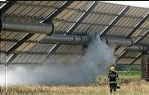
Los generadores fotovoltaicos tienen riesgos específicos de incendio por la presencia de puntos calientes en paneles fotovoltaicos, calentamientos y/o arcos eléctricos en interior de paneles, baterías, caja de conexión, inversores, y cableado de corriente alterna. Los riesgos están agravados por el desgaste por su exposición al intemperie.
