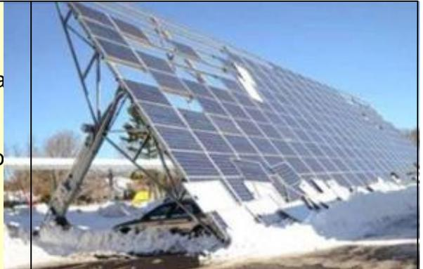
El viento más peligroso para un seguidor solar es el que se dirige hacia el ecuador (viento proveniente del Norte en el hemisferio Norte y del Sur en el hemisferio Sur), ya que es el que ejerce más fuerza dado que incide perpendicularmente en toda la superficie de paneles provocando esfuerzos de tracción.
