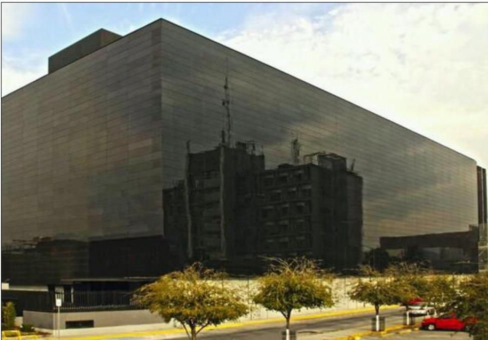
En México, se llevó a cabo en Monterrey la instalación de la primera fachada fotovoltaica del país. El proyecto fue realizado para la sede de FEMSA, la principal embotelladora de Coca Cola. El mismo consiste en 400 paneles que respetan los valores arquitectónicos y estéticos del edificio además de generar energía eléctrica capaz de evitar la emisión de 7 toneladas de CO<sub>2</sub> al año.
