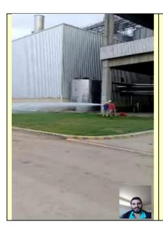
Prueba del sistema de agua de instalación contra incendio, realizada "on line" por el personal de la planta, durante una inspección de forma remota
