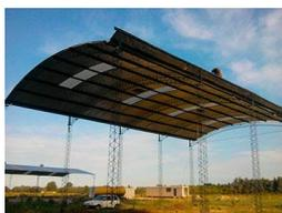
**Tipo 6:** Estructura de acero liviana, sobre piso/radier de hormigón alisado, sin cerramientos y techo parabólico de chapas acanaladas.
