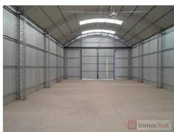
**Tipo 5:** Estructura de acero liviana, sobre piso/radier de hormigón alisado, cerramiento y techo parabólico de chapas acanaladas, sobre perfiles soldados de acero tubular de sección redonda.
