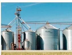
**Tipo 2:** Planta de Silos, con silos de metálicos, elevadores de cangilones, secadoras, balanza y prelimpieza.
