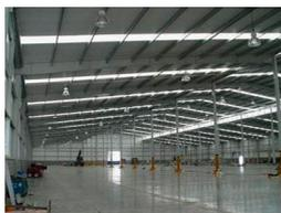
**Tipo 4:** Estructura de marcos de acero a dos aguas y cerramientos de mampostería, sobre piso/radier de hormigón alisado, techo de chapas acanaladas sobre perfiles soldados de acero.
