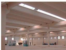
**Tipo 2:** Estructura de hormigón armado “prefabricado”, Pilares, vigas y losetas pretensados, cerramientos de paneles premoldeados, sobre piso/radier de hormigón alisado.
