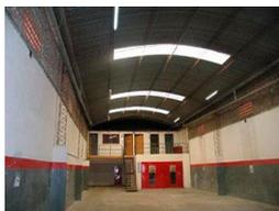
**Tipo 3:** Estructura y cerramientos de mampostería, sobre piso/radier de hormigón alisado, techo parabólico de chapas acanaladas, sobre perfiles soldados de acero tubular de sección redonda.
