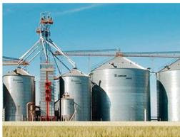
**Tipo 2:** Planta de Silos, con silos de metálicos, elevadores de cangilones, secadoras, balanza y prelimpieza.
